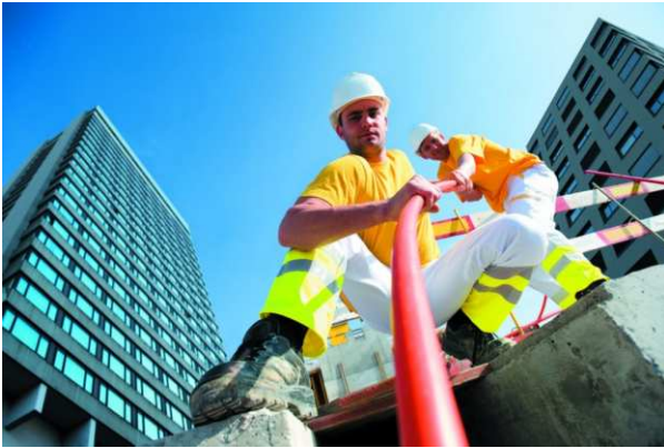
Εικόνα 1. Εγκατάσταση Δικτύου Νέας Γενιάς (FTTx) στο Brownfield Land.
