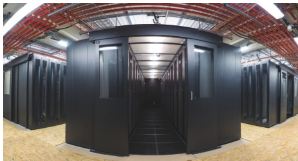
Σχήμα 2. Τοποθέτηση σε διάταξη Containment
