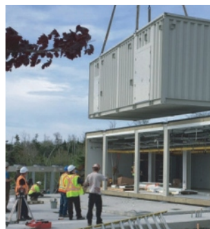
Σχήμα 3. Τοποθέτηση μιας PFM μονάδας
