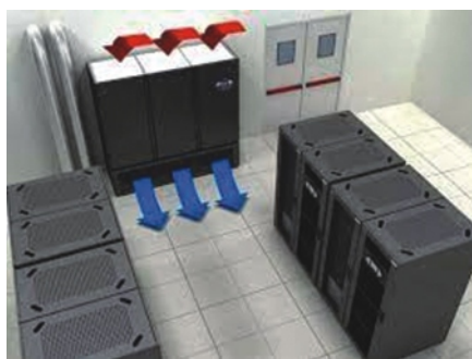
Εικόνα 5. Λύση Displacement-Frontal χωρίς ψευδοπάτωμα
